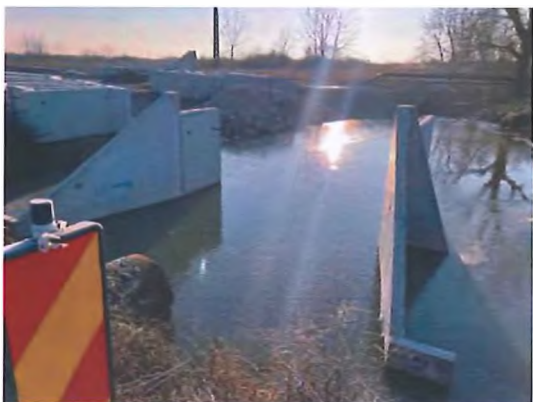
Fig. 6.5.31-2 - Situație demarare lucrări
