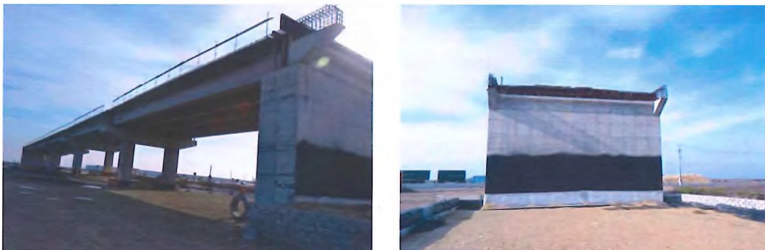
Fig. 6.7.4-2 Aspecte generale pasaj km 5+366
