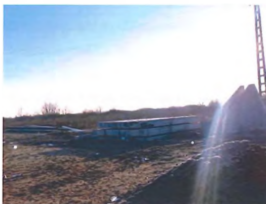
Fig. 6.5.31-4 - Depozitare dale prefabricate prefabricate tip D5
