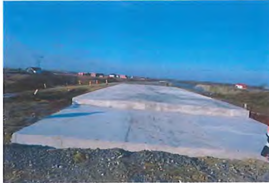
6.7.10-1 Vedere de ansamblu stadiu structură km 18+926
