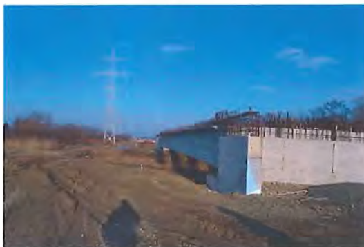
6.7.11-1 Vedere de ansamblu stadiu structură km 20+875
