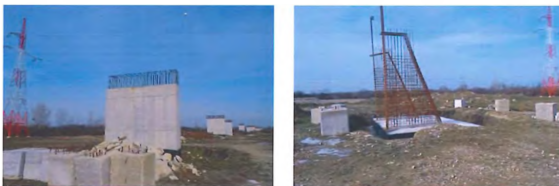
Fig. 6.7.2-1 Aspecte elevații culee
