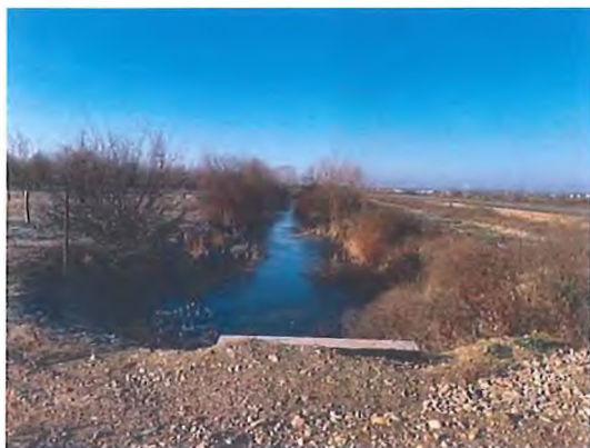
Fig. 6.5.33-12 - Capăt podeț aval
