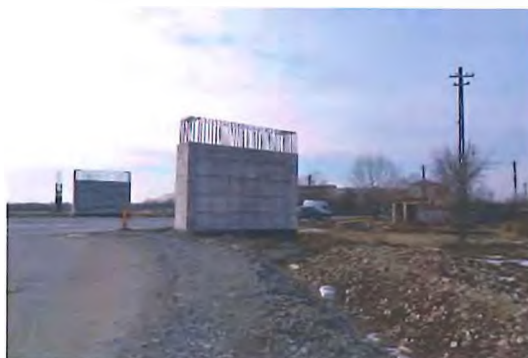
Fig. 6.7.1-1 Aspecte generale –stadiul structurii km 0+608
