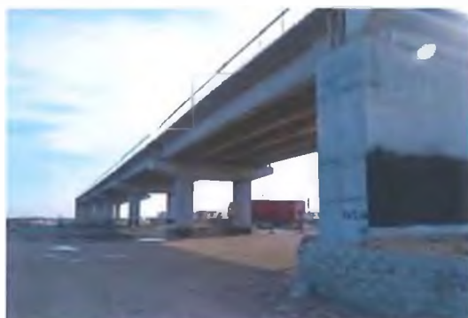
Fig. 6.7.4-1 Aspecte generale pasaj km 5+366
