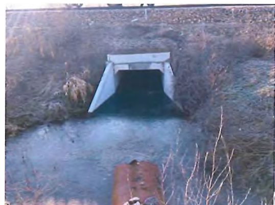
Fig. 6.5.33-8 - Capăt podețe amonte
