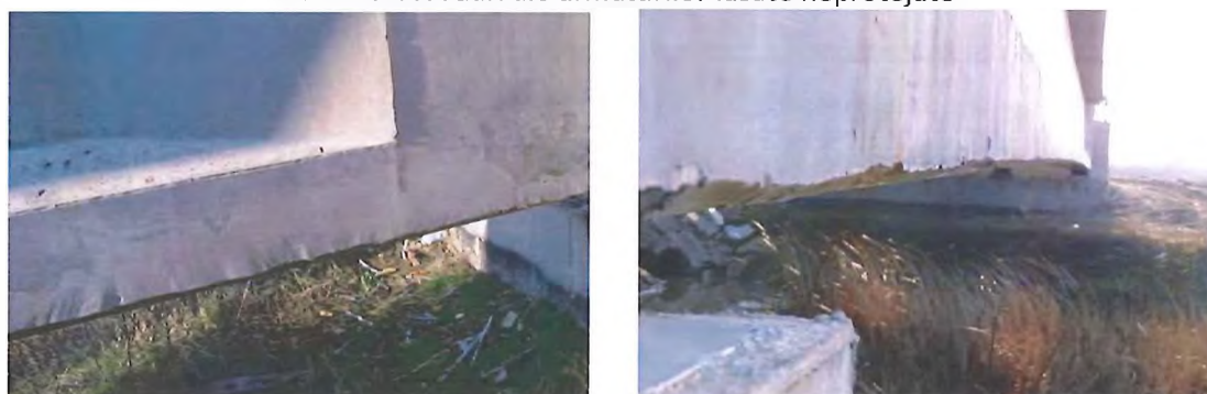
6.7.11-4 Aspecte grinzi/zona cu reparații
