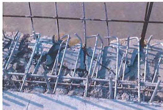
Fig. 6.7.6-7 Placa superioară a grinzii marginale, lovite
