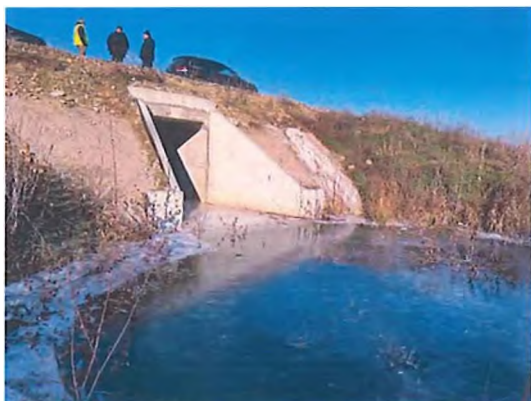
Fig. 6.5.33-20 - Capăt podeț aval
