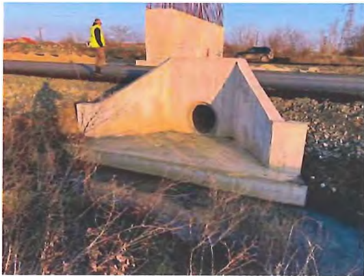
Fig. 6.5.29-2 - Capăt podeț aval
