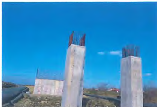
Fig. 6.7.9-1 Vedere de ansamblu stadiu structură km 18+117
