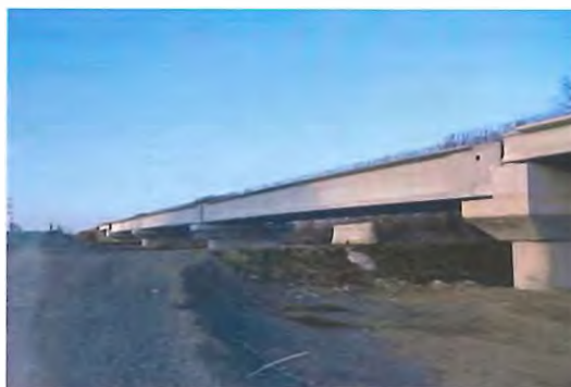
6.7.12-1 Vedere de ansamblu structură km 24+725
