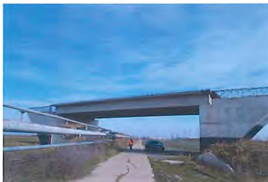
Fig. 6.7.3-1 Aspecte general structura km 3+509
