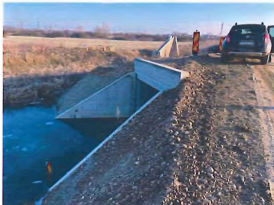
Fig. 6.5.32-2 - Capăt podeț aval
