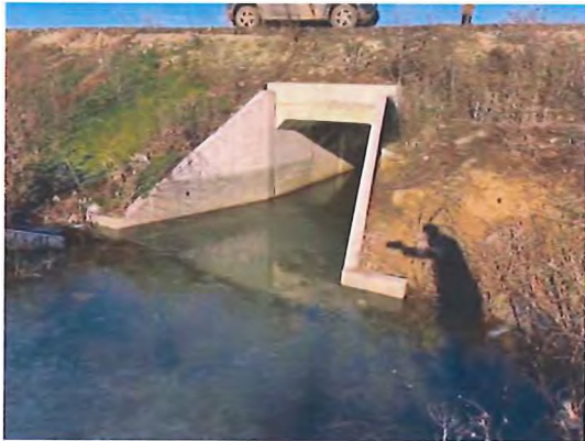
Fig. 6.5.33-17 - Capăt podeț aval
