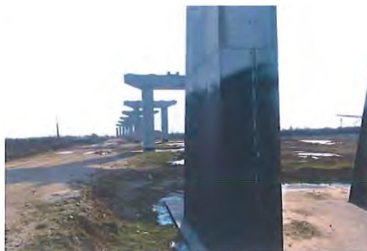
Fig. 6.7.8-1 Vedere de ansamblu stadiu structură km 15+072
