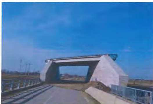
Fig. 6.7.7-1 Vedere de ansamblu structură km 11+576
