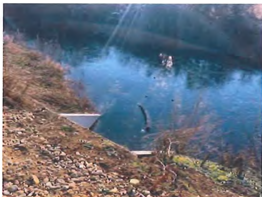
Fig. 6.5.33-10 - Capăt podeț aval
