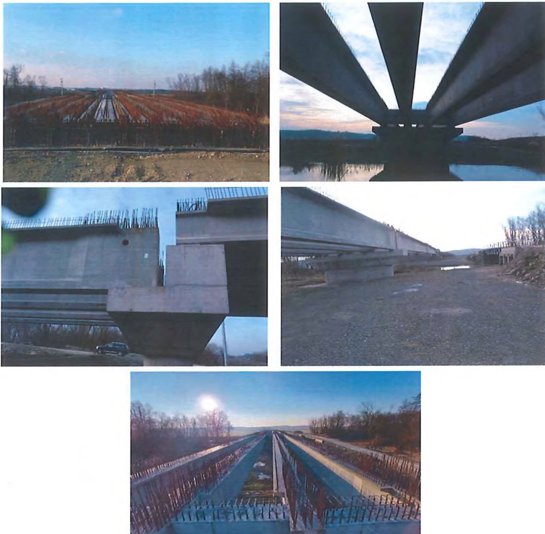
6.7.12-2 Aspecte generale pod - Montaj grinzi
