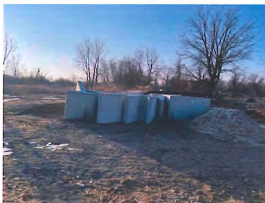
Fig. 6.5.31-3 - Depozitare elemente prefabricate tip L3
