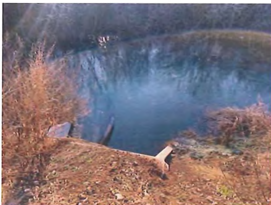
Fig. 6.5.33-7 - Capăt podeț aval
