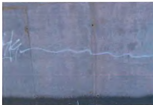
Fig. 6.7.7-3 Fisuri verticale
