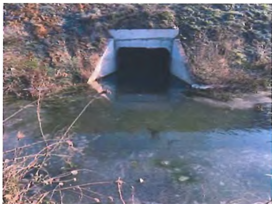
Fig. 6.5.33-26 - Capăt podeț aval
