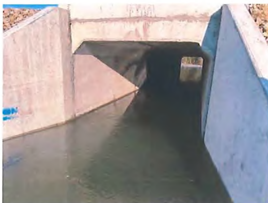
Fig. 6.5.33-15 - Capăt podeț aval
