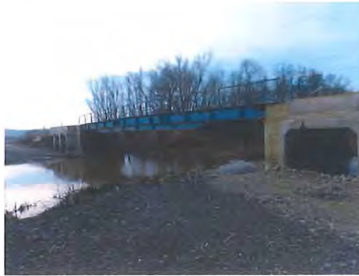
6.7.12-5 Vedere ansamblu pod provizoriu peste Bega
