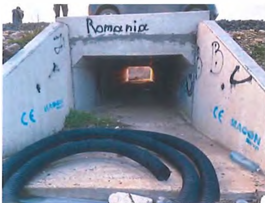
Fig. 6.5.29-4 - Capăt podeț aval
