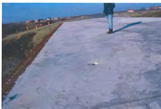
6.7.10-3 Vedere de ansamblu placă – zona gurii de scurgere
