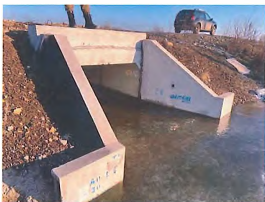
Fig. 6.5.32-6 - Capăt podeț aval
