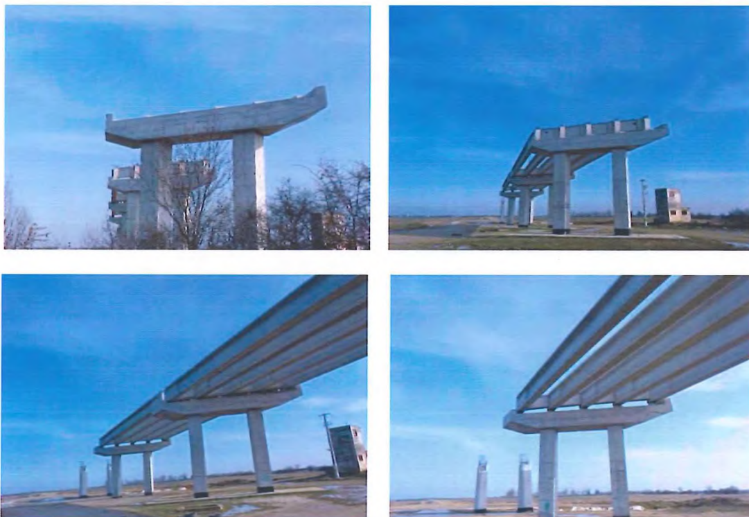
Fig. 6.7.5-2 Situație existentă pile – Grinzi montate pe deschiderile 7-8
