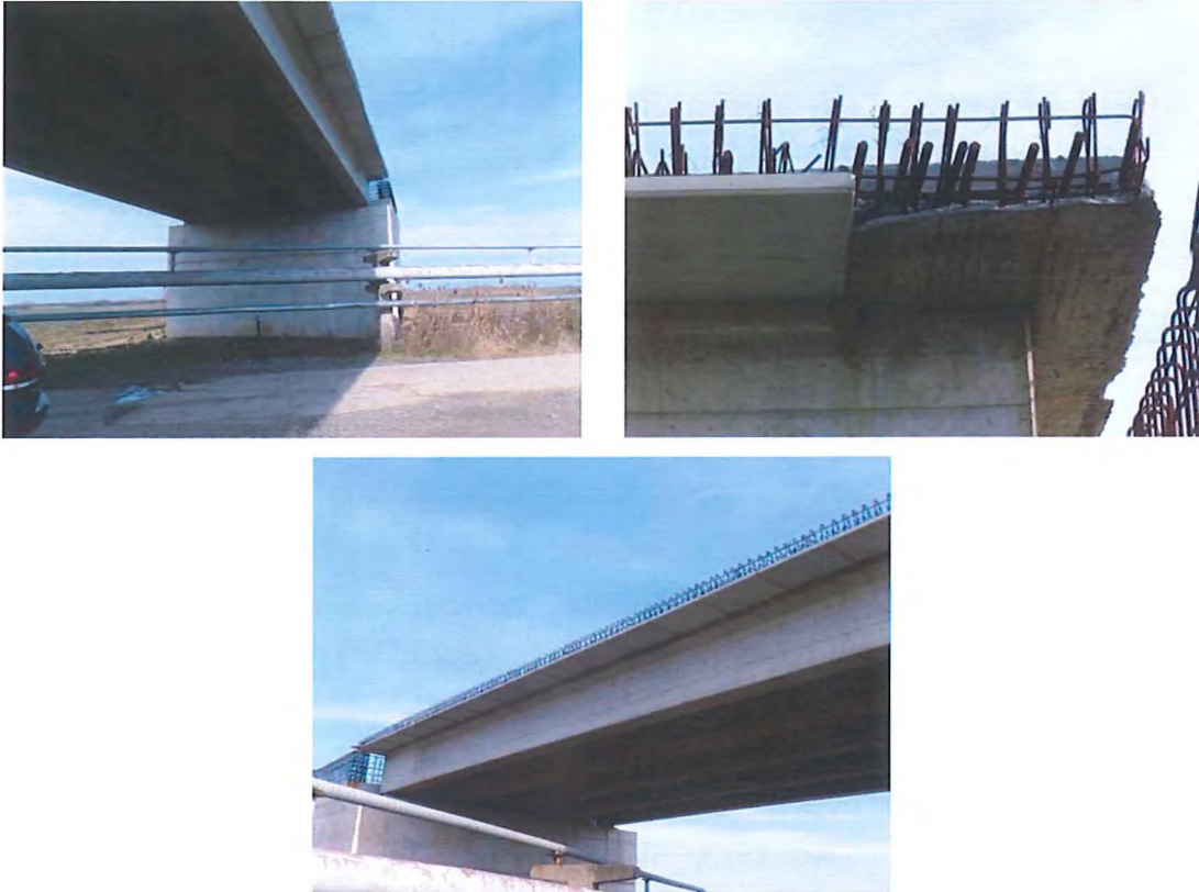
Fig. 6.7.3-3 Aspecte generale suprastructura pasaj
