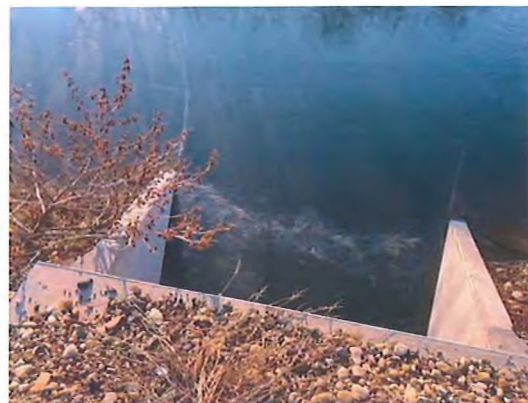
Fig. 6.5.33-5 - Capăt podeț aval
