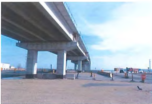
Fig. 6.7.4-6 Vedere intrados deschiderea 2 și pila P2
