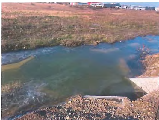
Fig. 6.5.33-28 - Capăt podeț aval
