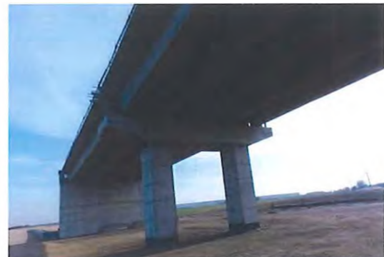
Fig. 6.7.4-7 Vedere intrados deschiderea 4 și pila P4
