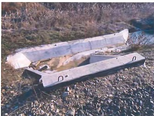
Fig. 6.5.33-23 - Capăt podeț aval
