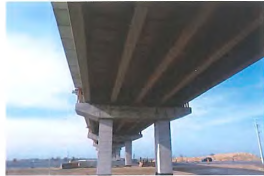
Fig. 6.7.4-5 Vedere intrados deschiderea 1 și pila P1
